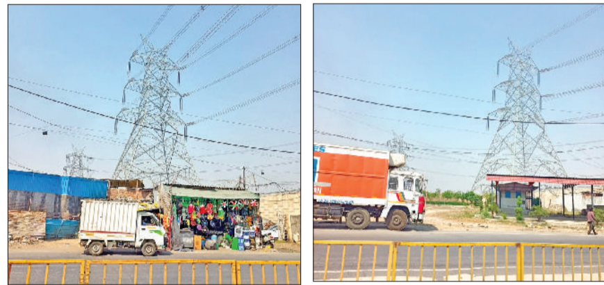
सोनीपत। हाईटेशन लाइन के लिये लगाए गए टावर।
